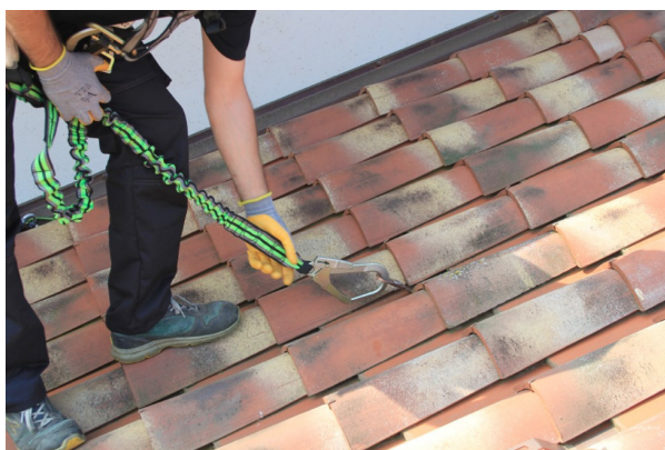
15. Collegamento all'ancoraggio
